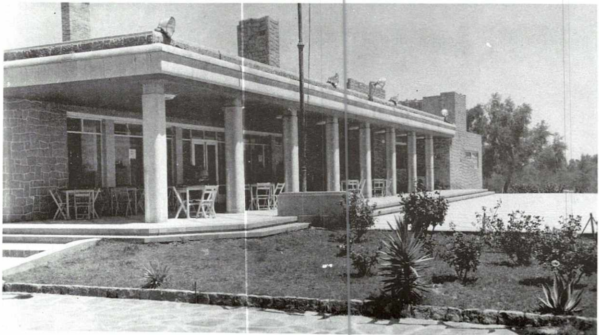
El edificio del Club tenía al principio una sola planta, el proyecto arquitectónico es obra de los arquitectos Algara y Cossío, a cuyo cargo también estuvo la construcción. Aquí vemos una vista de la terraza y el edificio principal, el cual ostenta sus columnas originales, las que quedaron tapadas cuando se realizó la obra de la actual cafetería.
