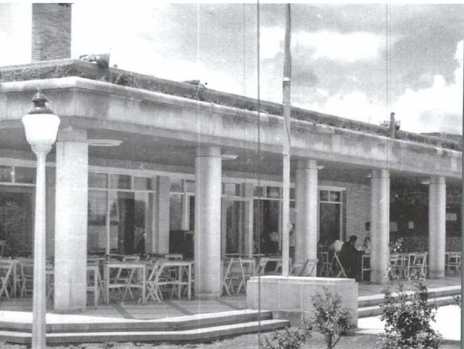
Instalaciones del Club Deportivo Potosino en la década de 1950.
