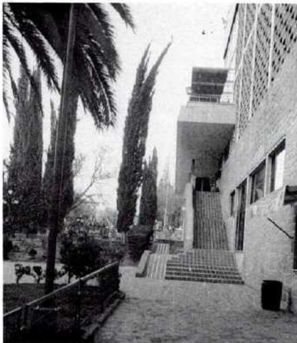
Area norte de la fachada, que fue limpiada totalmente
